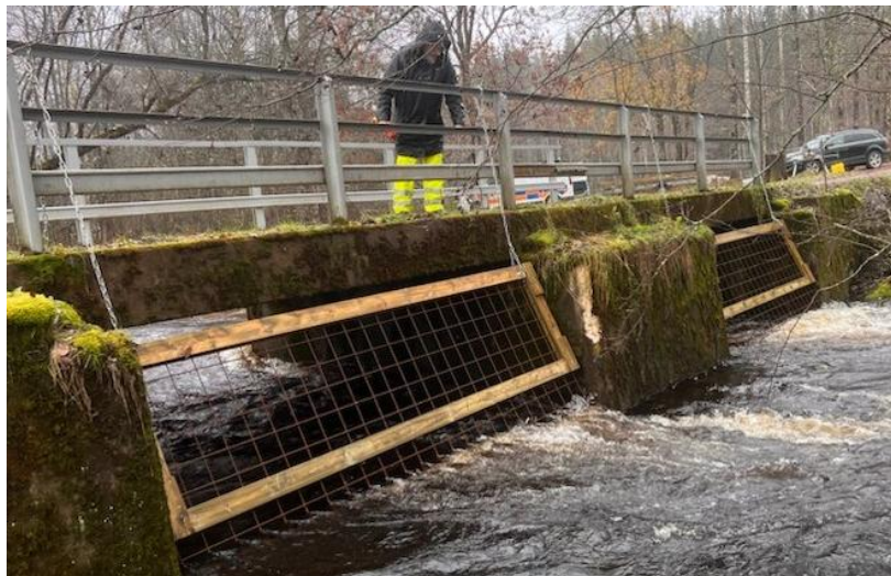
Exempel på galler som förhindrar vildsvin att ta sig fram i vattendrag. Källa: Jordbruksverket.
