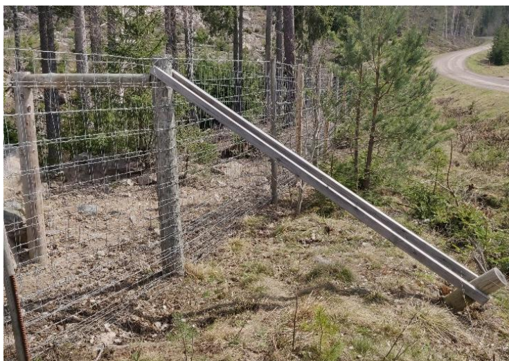
Exempel på stagning (vilthägnsstängsel). Källa bild: Jordbruksverket
